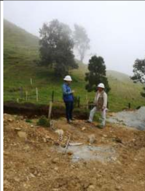
Visita a PTAP, evidencia de excavaciones y solados de limpieza
