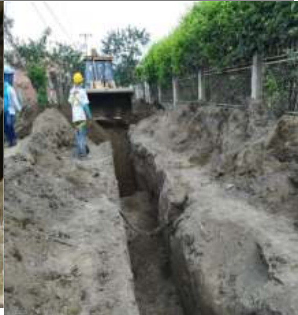
PROCESO DE EXCAVACION DONDE SE OBSERVA LO ANGOSTO DE LA VIA.
