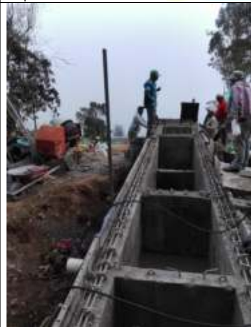
Fundición de Desarenador
