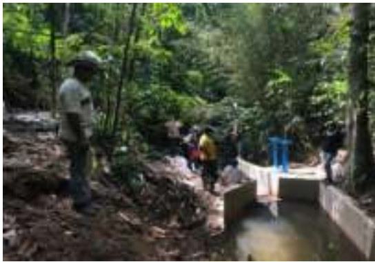
Recorrido estructuras PTAP San Isidro - El Chuzo - Bocatoma
