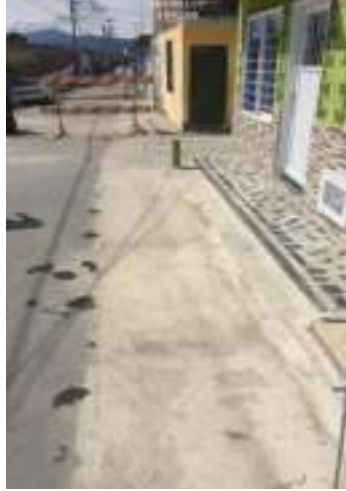
Reposición de andenes
