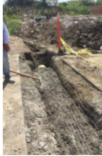
Recubrimiento tubería, manejo de aguas lluvias
