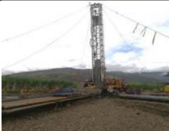
Máquina perforadora del pozo
