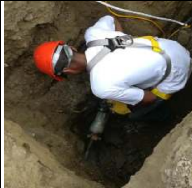
ROTURA DE CAMARA DE ALCANTARILLADO PARA REALIZAR EMPALME CON LAS NUEVAS REDES INSTALADAS.
