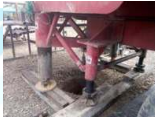
Inicio de perforación para prueba de bombeo
